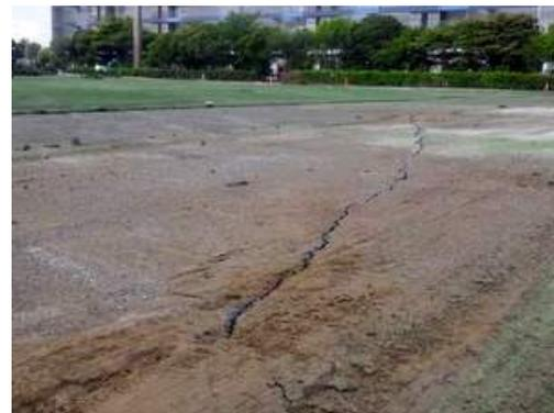
▲デコボコの原因は人工芝裏の「液状化で湧き出た土」と「ひび割れたアスファルト」
